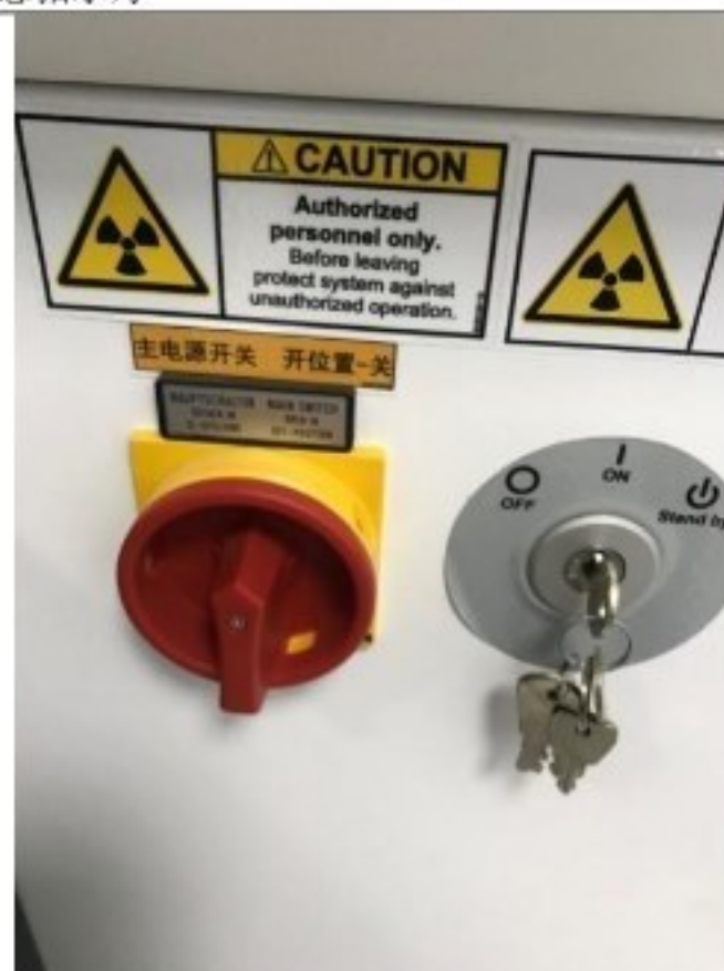
自屏蔽体外主电源开关和出束开关
